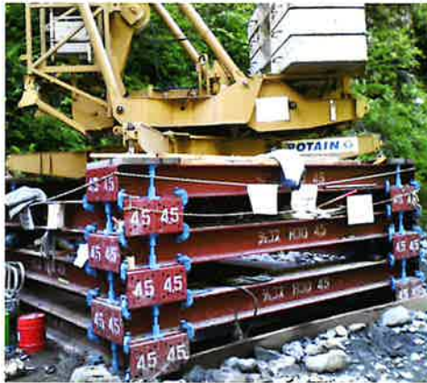
バンド材にてかさ上げ
